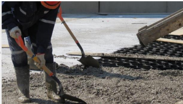
3. Se vacía el concreto sobre la GEOCELDA
