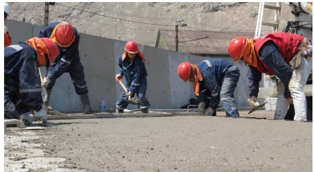
4. Se distribuye el relleno, se compacta y se nivela
