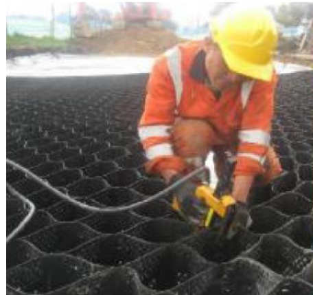
2. Se conectan las secciones de la GEOCELDA y se ancla.
