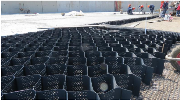
1. Expandir la GEOCELDA sobre la base compactada
